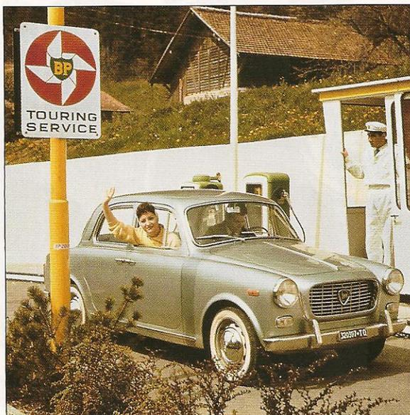
Dall'alto, nella sua 2<sup>a</sup> serie, la Lancia Appia è stata oggetto di un profondo restyling di carrozzeria. La potenza del motore è salita a 44 CV, per una velocità massima di 128 km orari. E' stata prodotta dal 1956 al 1959.
